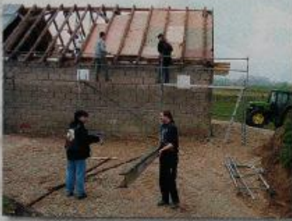
Durch viel Eigenleistung wurde das neue Clubhaus ...
